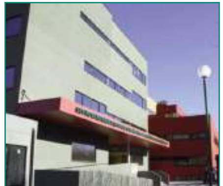
Fachada del centro
